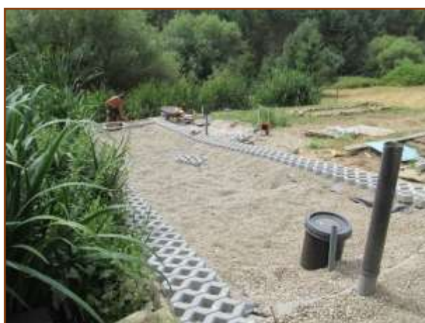
Fot. 16. Wykonanie betonowych obrzeży złoża
