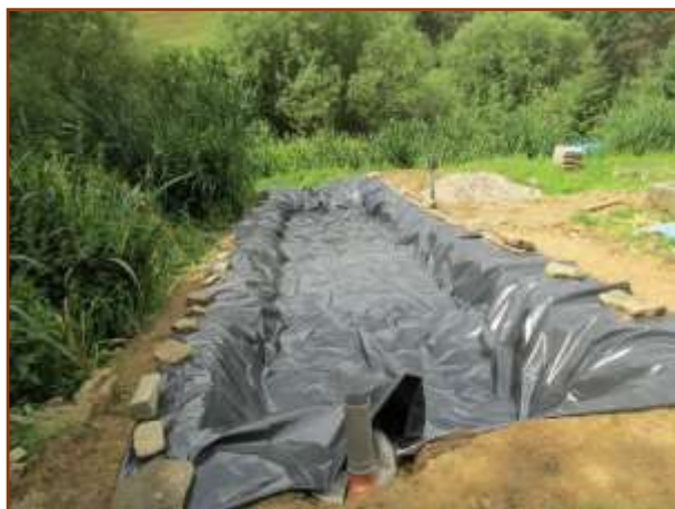
Fot. 14. Ułożenie izolacji z folii PE
