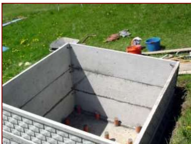
Fot. 5. Obudowa złoża w stanie surowym
