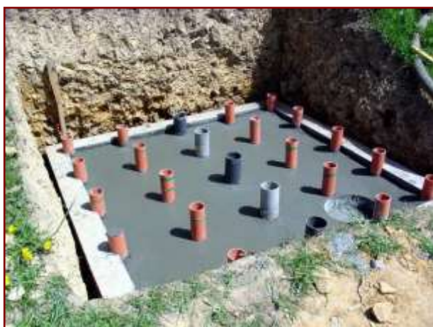
Fot. 3. Wylewka oraz wsporniki dystansowe rusztu
