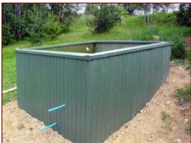
Fot. 7. Wykończenie obudowy trapezową blachą elewacyjną
