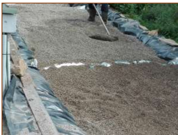
Fot. 15. Wypełnienie złoża mieszanką mineralną
