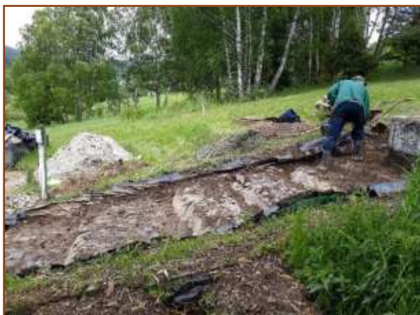
Fot.13. Wykop pod złożę i wstępne zabezpieczenie jego powierzchni
