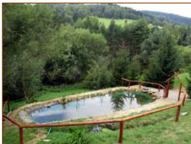
Fot. 22. Wykonanie ogrodzenia zabezpieczającego
