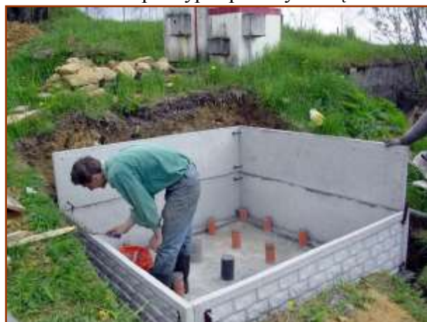
Fot. 4. Montaż ścian z płyt betonowych
