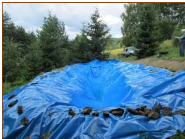
Fot. 19. Wykonanie wykopu oraz uszczelnienie niecki folią basenową
