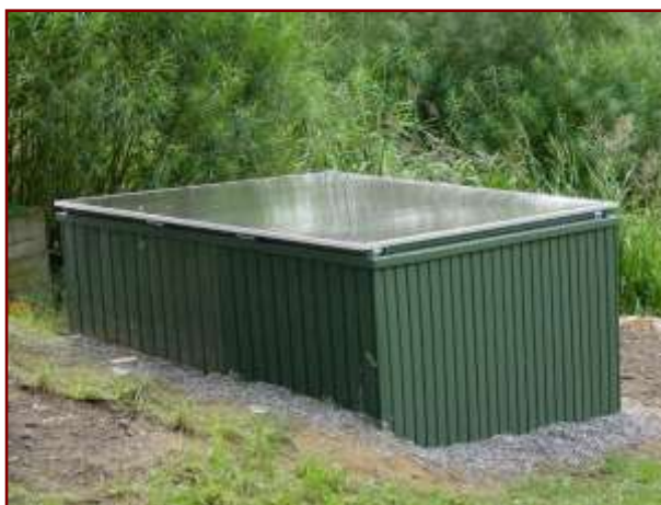
Fot. 12. Kompletnie złoże przykryte transparentną płytą z poliwęglanu.
