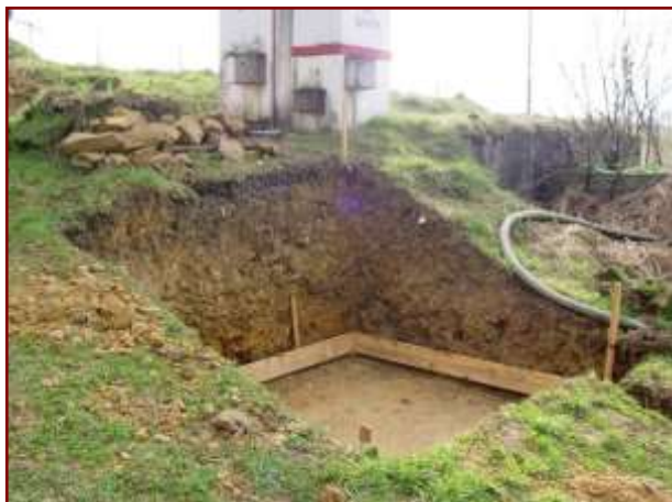
Fot.1. Wykop pod złożo
