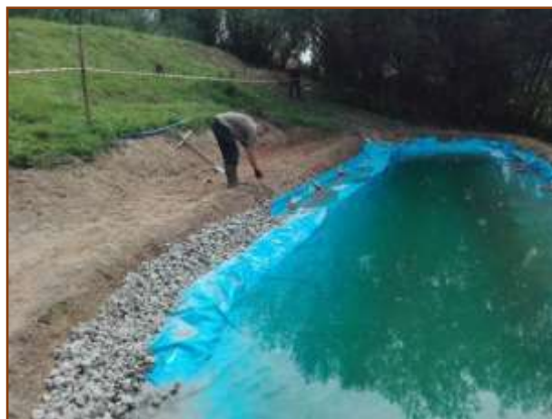
Fot. 20. Zabezpieczenie obrzeży folii obsypką kamienną
