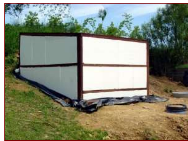
Fot. 6. Ocieplenie obudowy płytami styropianowymi
