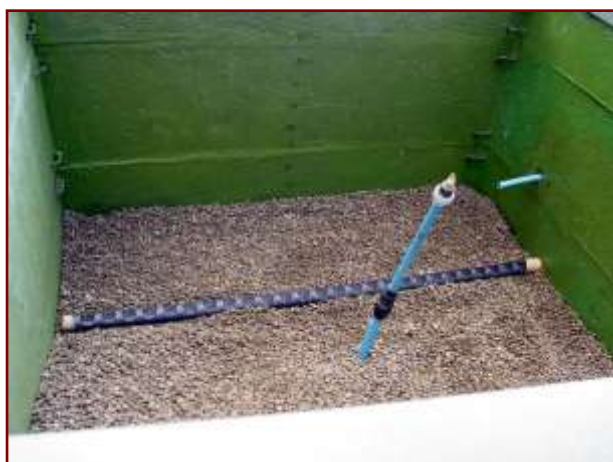
Fot. 9. Wypełnianie złoże keramzytem
