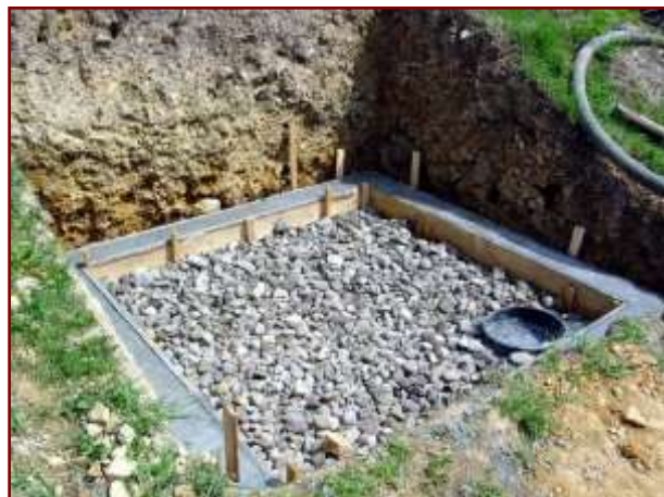
Fot. 2. Wykonanie zbrojonego fundamentu oraz podsypki pod wylewkę
